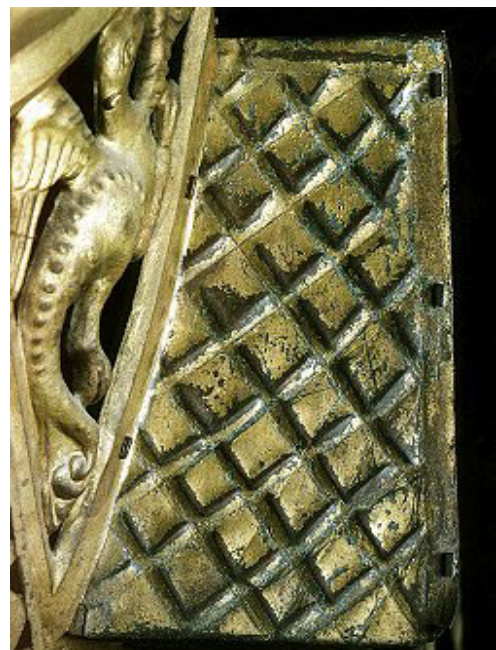
Dachfläche nach Entfernen der Wachsschicht
